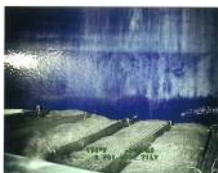
ガラスライニングを施した容器内部の検査
